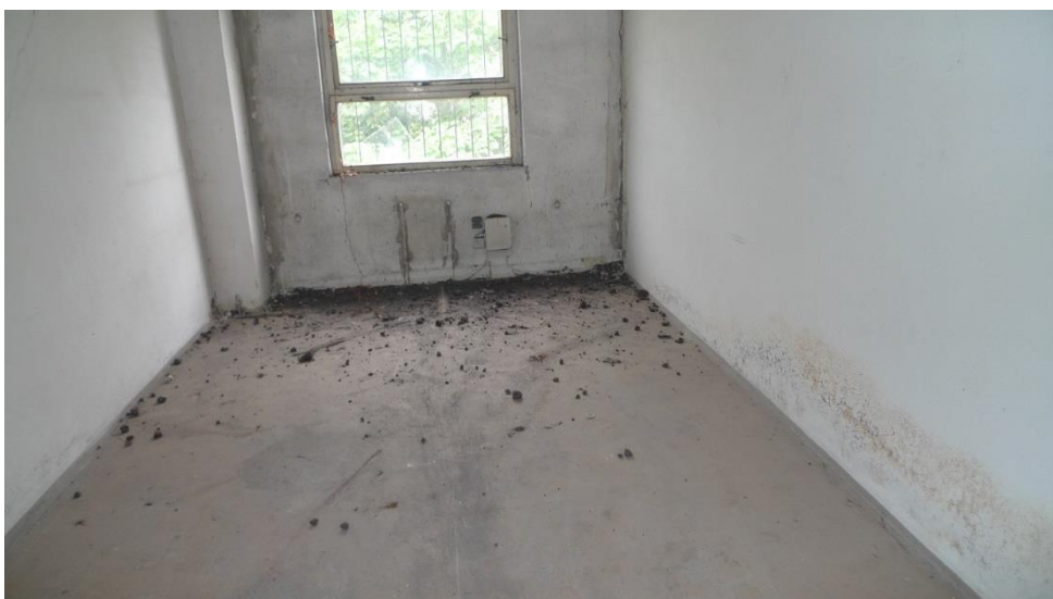
obr. 3 Škvárový násyp střechy na podlaze
