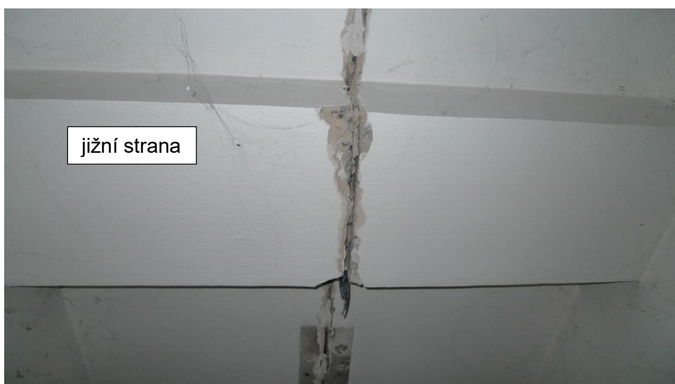
obr. 9 Styk průvlaků nad chodbou nepodsklepené části
