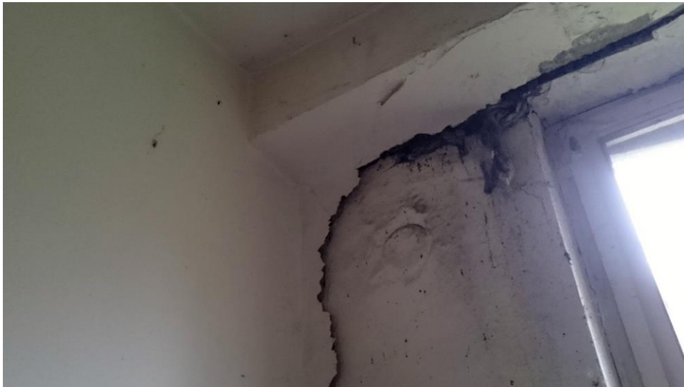
obr. 4 Porovnání u obvodové stěny (2016)
