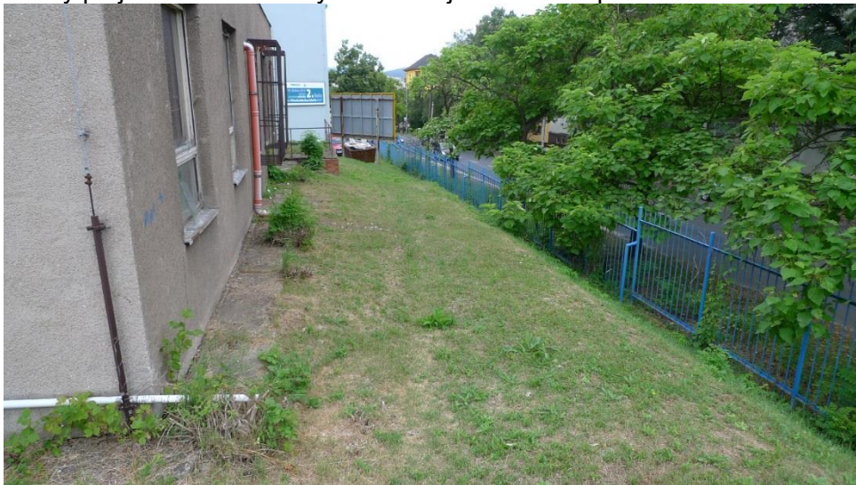
obr. 17 Svažité terén násypu u jižní fasády objektu
