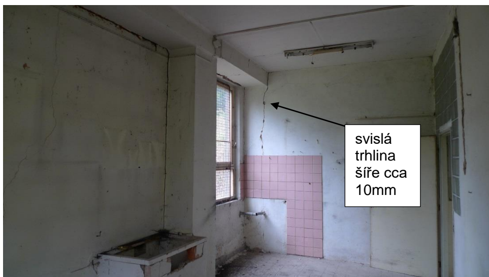
obr. 6 Západní fasáda proti chodbě
