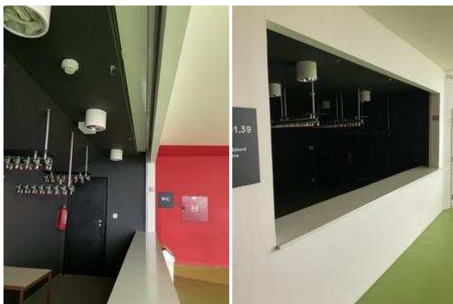
Obrázek 3 - požární oddělení šaten s lokálním SHZ
