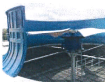
Obr. 15.7 Difúzor chladicí věže s nuceným tahem [80]
