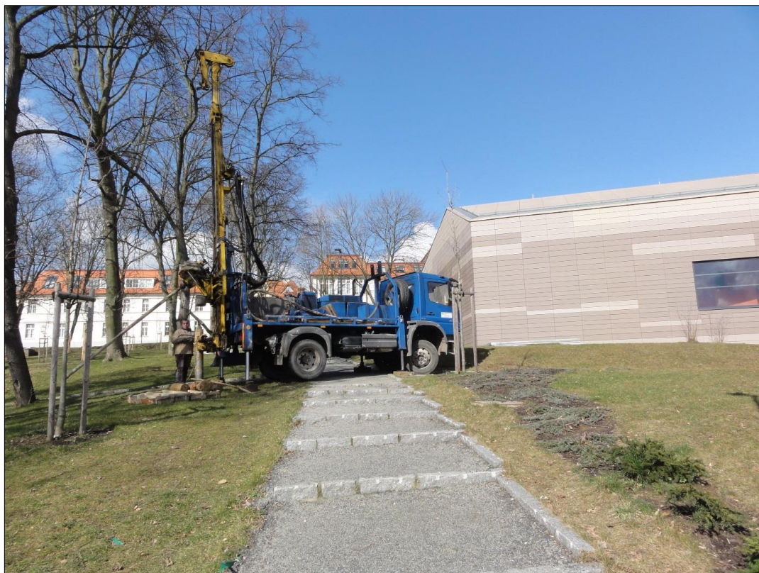
Obrázek 4: Provádění vrtané sondy N3
